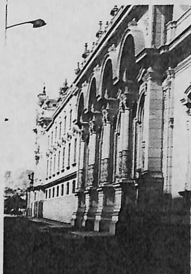
FACHADA LATERAL. Palacio de Gobierno.
