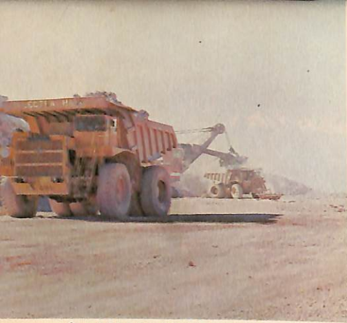
▲ CERRO VERDE. Pala P.E. Modelo 1900 - 11 yardas cúbicas de alzada, cargando camiones Lectra - Haul de 85 ton. cortas.
